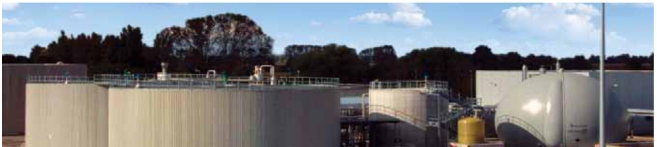
FIGURA 13: DIGESTORI ANAEROBICI, I REATTORI IN CUI AVVIENE LA FERMENTAZIONE E LA PRODUZIONE DI BIOGAS
